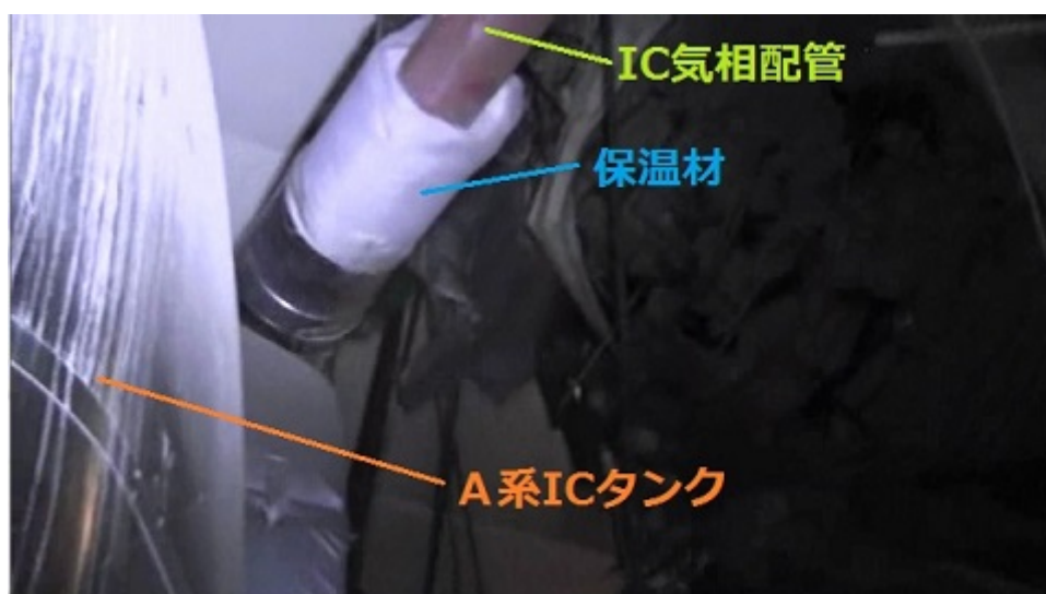
写真 1 1 : 非常用復水器北側の保温材脱落状況 (甲 A 5 0 4)
