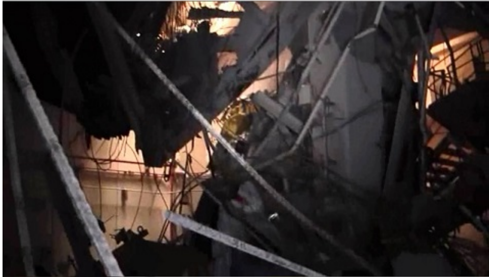
写真9：原子炉建屋4階北側天井の破損開口部の状況（甲A504）
