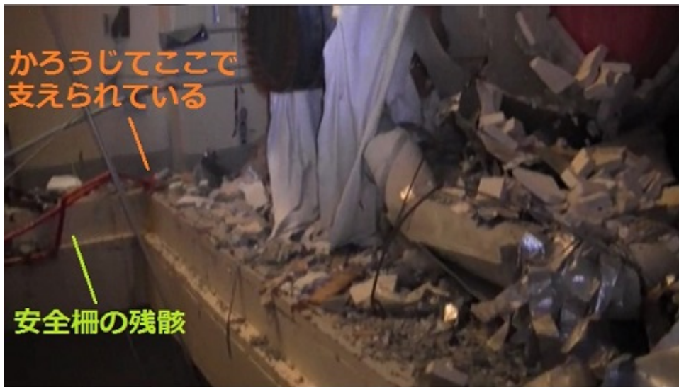
写真4：4階大物搬入口北側安全柵が失われた状況（甲A504）
