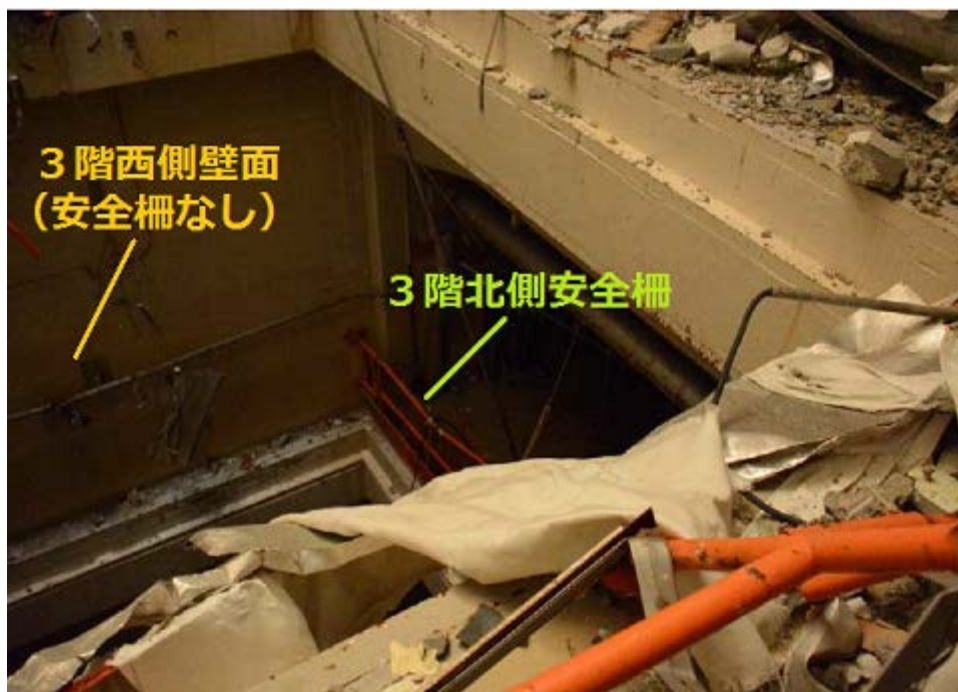
写真6：3階大物搬入口西側及び北側の状況（甲A505「1号機4階における出水事象に関する現地調査結果について 11) 」25頁）
