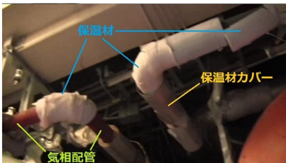
写真2：非常用復水器南側気相配管の保温材脱落状況（甲A504）
